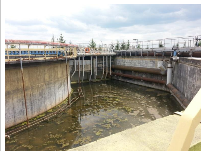
Komora napowietrzania w reaktorze niesfunkcjonującym
