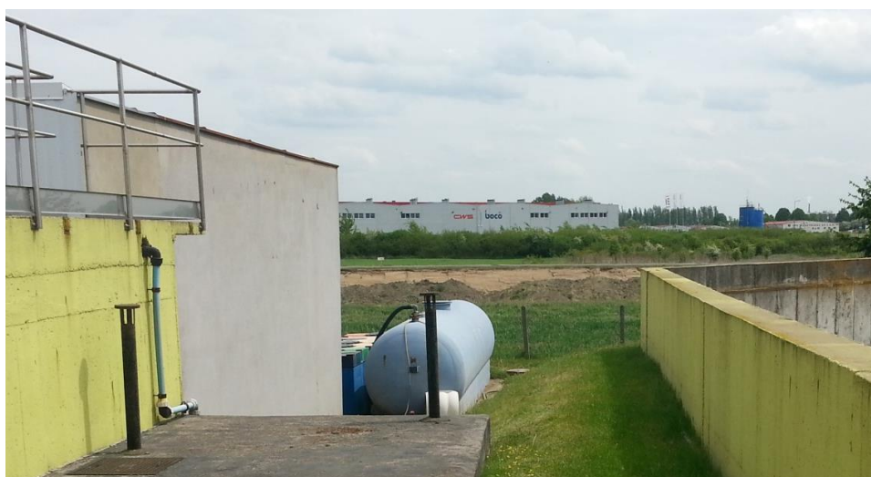
Zbiornik PIX (obiekt nr R2) - rozbiórka
