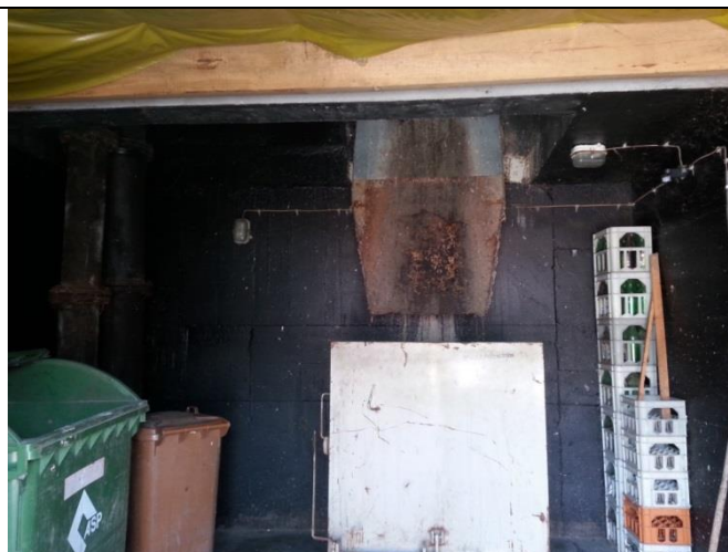
Zrzut skratek znajdujący się na poziomie 0 - będącym częścią boks magazynowy przewidzianego do przebudowy na budynek magazynowy - ob. nr 15.
