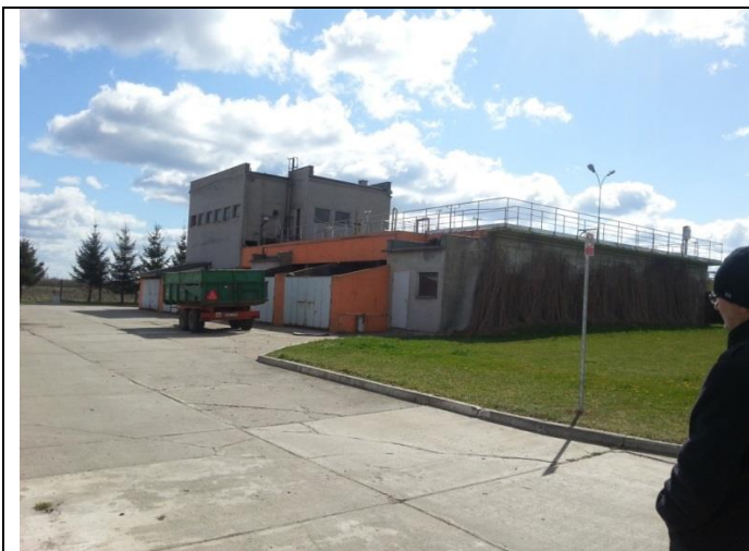
Osadnik wstępny do przebudowy na zb. retencyjny ścieków, na froncie boksy do przebudowy na budynek magazynowy (ob. nr 15), z tyłu budynek krat.
