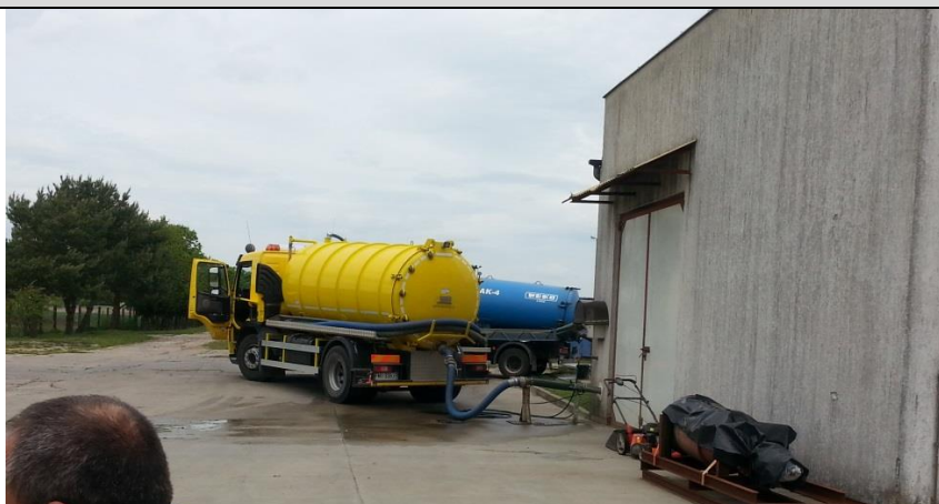
Stacja zlewna zlokalizowana jest w budynku odwadniania osadów, odbiór ścieków odbywa się poprzez wpust na zewnętrznej ścianie budynku.
