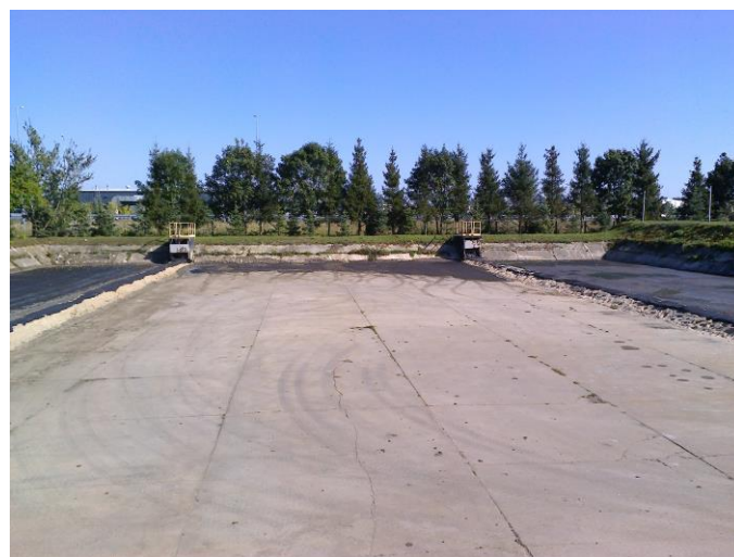
Obiekt nr R1B
