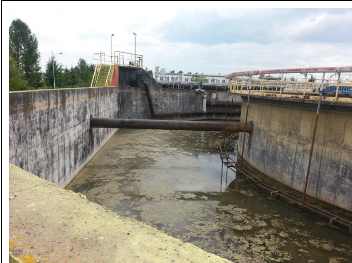
Komora napowietrzania w reaktorze niesfunkcjonującym
