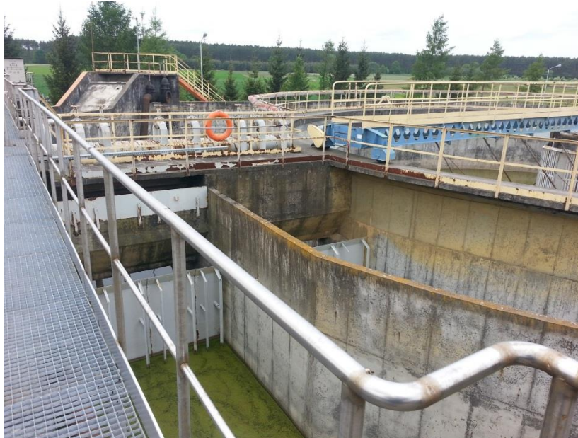
Laguny osadowe (obiekty nr R1A, R1B) - rozbiórka
